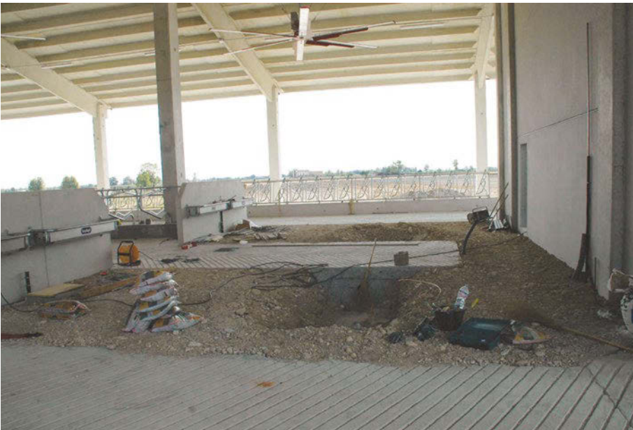
All'inizio della nuova stalla saranno installati i due robot Lely A4 di prossima acquisizione.
